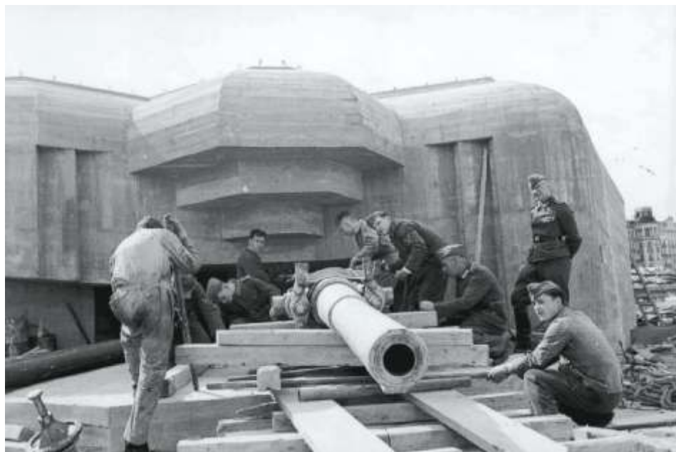
Строительство Атлантического вала, 21 июня 1943 г.
